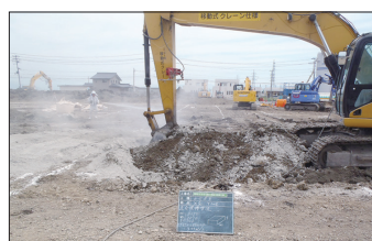
09 二次改良 区割り寸法確認、 セメント散布、混合攪拌状況
