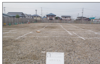
05 一次改良 位置出し状況
