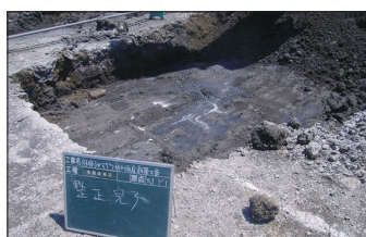
04 整正、整正完了
