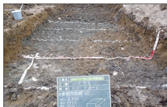
06 一次改良 スキトリ、 区割り寸法確認
