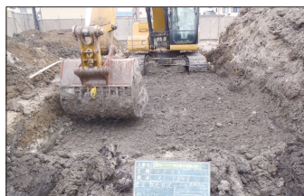
08 一次改良 整正・転圧状況
