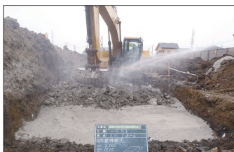
07 一次改良 セメント散布、 混合攪拌状況
