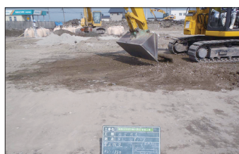
10 二次改良 整正状況
