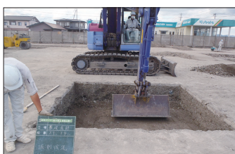
11 二次改良 掘削状況
