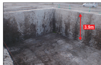
04 タンク部掘削完了
