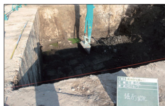
02 タンク部掘削
