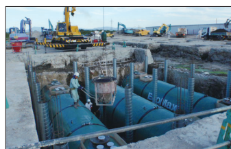
06 地下タンク設置状況
