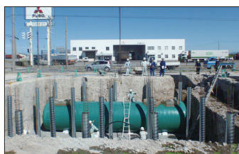
05 地下タンク設置状況
