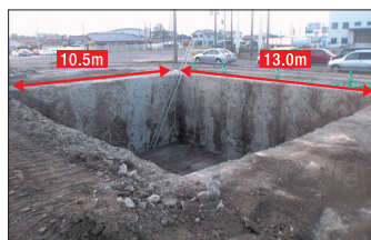
03 タンク部掘削完了
