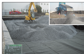
09 等粒石搬入・敷設
