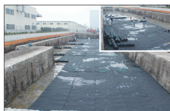
06 保護マット敷設
