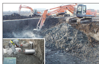
03 掘削・底盤改良
