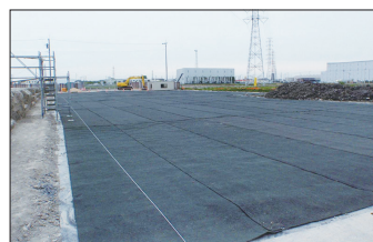
11 ジオテキスタイル敷設
