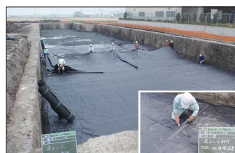
07 遮水シート敷設
