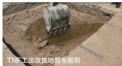
TNF工法改良地盤を掘削
