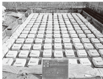
*冷凍倉庫(-25℃)での凍上防止施工例
