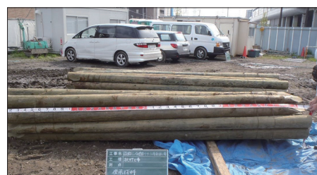
03 丸太杭搬入計測
