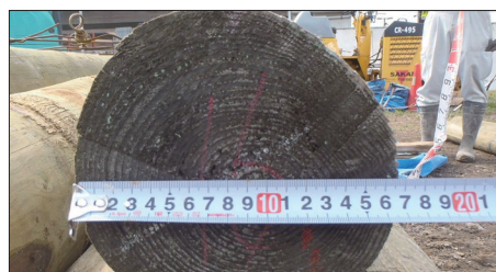
04 丸太杭搬入計測
