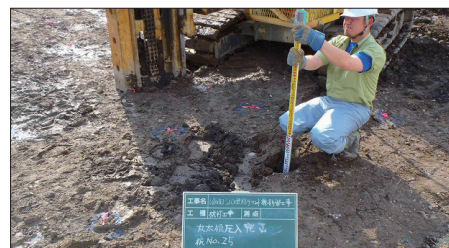
09 打設完了レベル測定
