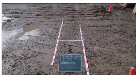
02 杭芯位置出し
